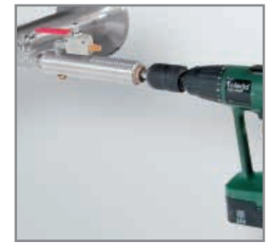
Anbohren unter Druck mit der CS Bohrvorrichtung
